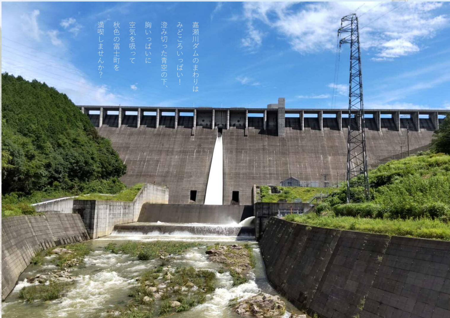
放流する嘉瀬川ダム(令和3年8月)
